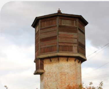
БАШНЯ ВОДОНАПОРНАЯ 1897 Г.
